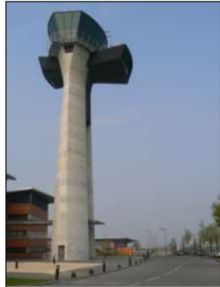
Tour de contrôle de l'aéroport
