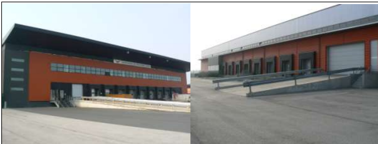
Aérogares de fret 1 et 2 de l'aéroport de Paris-Vatry
