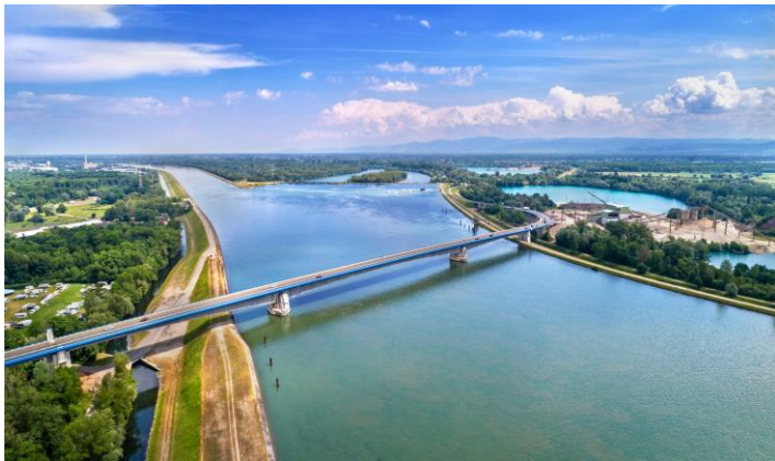
Pierre-Pfimplin-Brücke zwischen Frankreich und Deutschland - © Leonid Andronov
