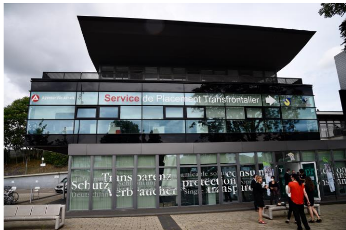
Bau der grenzüberschreitenden Arbeitsvermittlung in Kehl - © Stadler RGE
